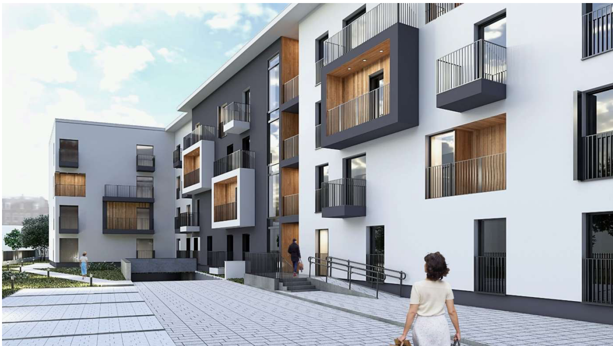
Elewacja zachodnia budynku
