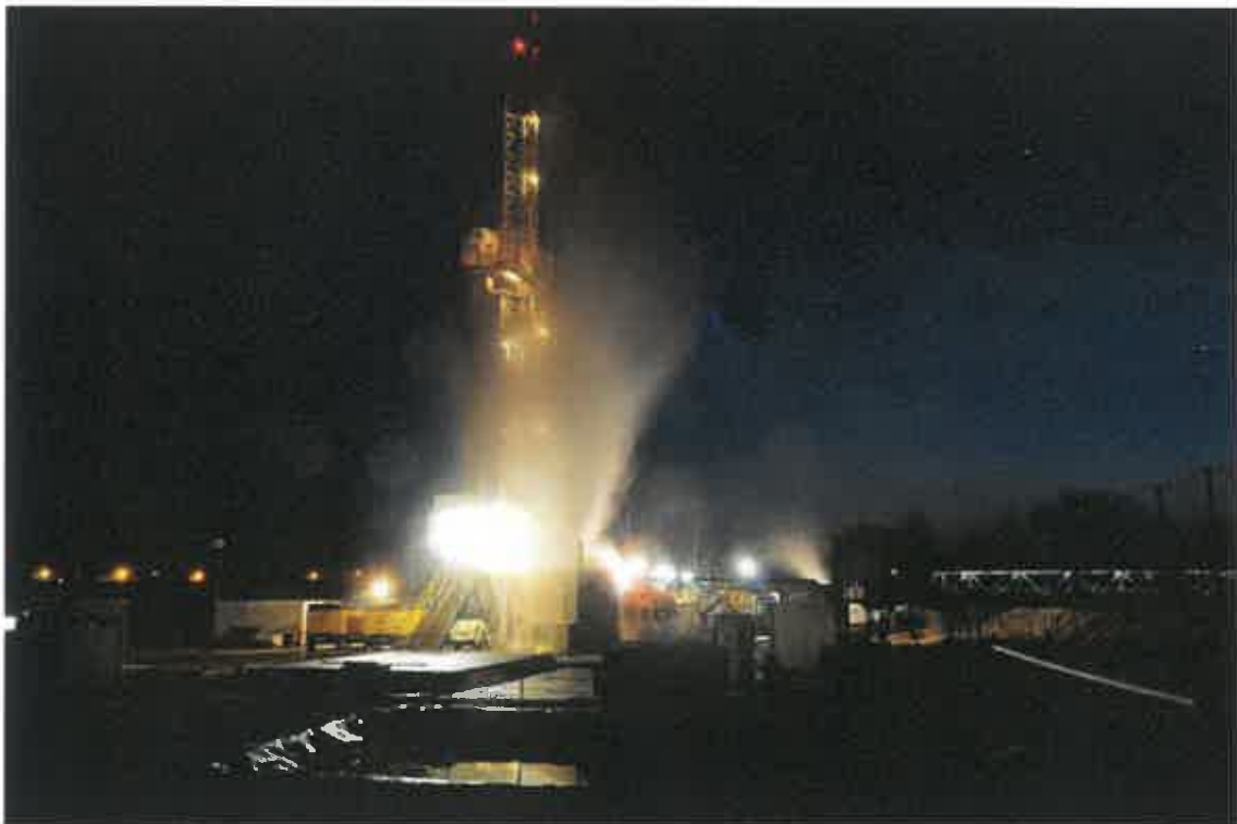
5. Budowa odwiertu GT - 1 w roku 2015 fot. M. Jurgielewicz
