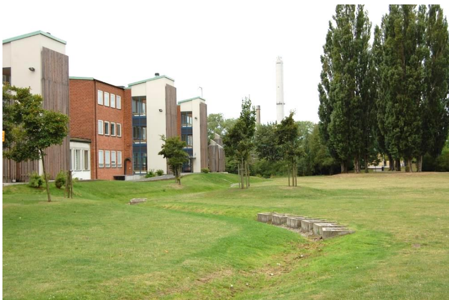
Ryc. 5. Niecka zbierająca wody opadowe z terenu zieleni. Fot. Łukasz Dworniczak
