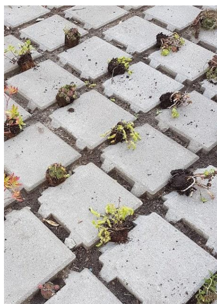
Ryc. 1. Nawierzchnia utwardzona przepuszczalna dla wody, wykonana z kostki betonowej. Fot. Łukasz Dworniczak
