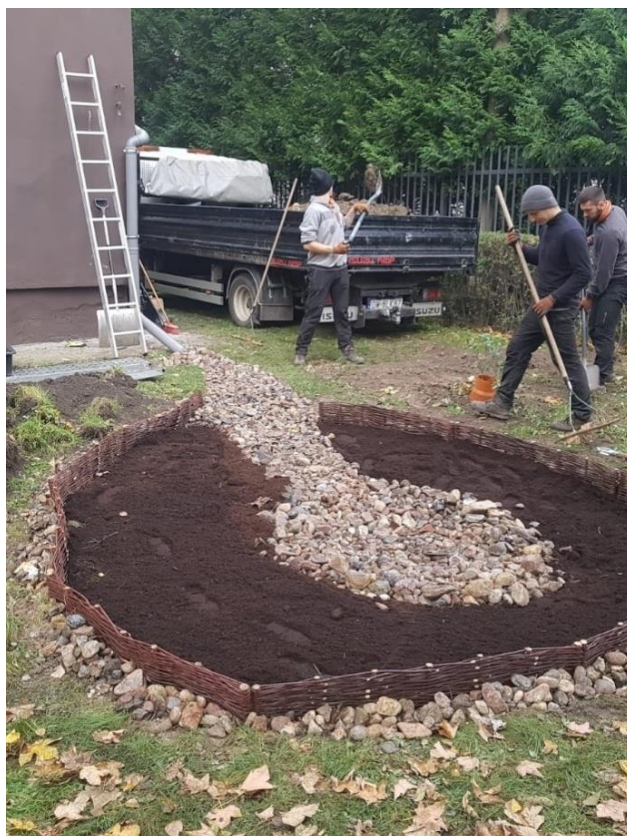
Ryc. 4. Ogród deszczowy i „kamienny rynsztok” sprowadzający wodę z rynny (w trakcie realizacji). Fot. Maciej Motas
