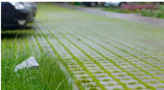
Ryc. 2. Nawierzchnie przepuszczalne z kostki betonowej na ciągach jezdnych i miejscach postojowych. Przykładowe rośliny wypełniające dylatację. Fot. Łukasz Dworniczak
