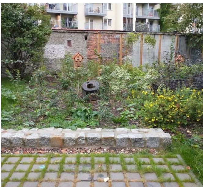
Ryc. 1. Nawierzchnia utwardzona przepuszczalna dla wody, wykonana z kostki betonowej. Fot. Łukasz Dworniczak
