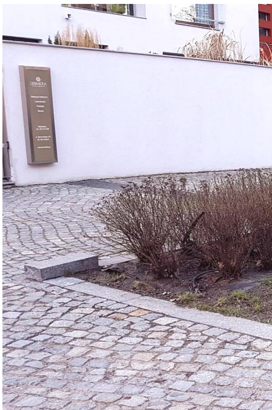
Ryc. 3. Obniżony krawężnik umożliwiający spływ wód opadowych pod zieleń. Fot. Łukasz Dworniczak
